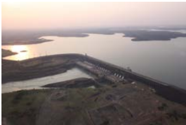
Planta Hidroeléctrica Itaipu
